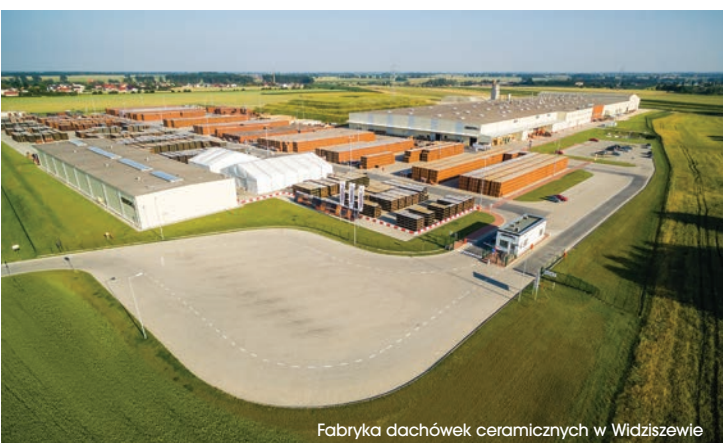
Fabryka dachówek ceramicznych w Widziszewie
